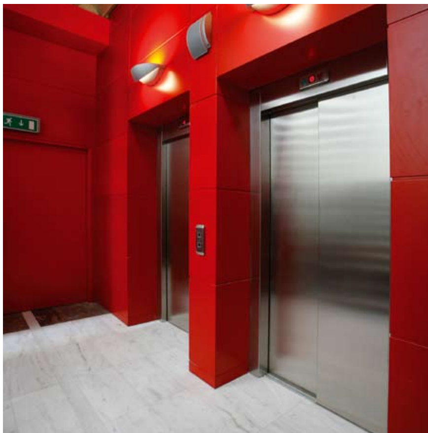
2-panel telescopic AUTOMATIC VVVF door
