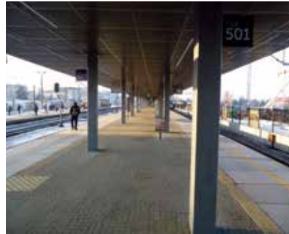
Railway stations Железнодорожные вокзалы
