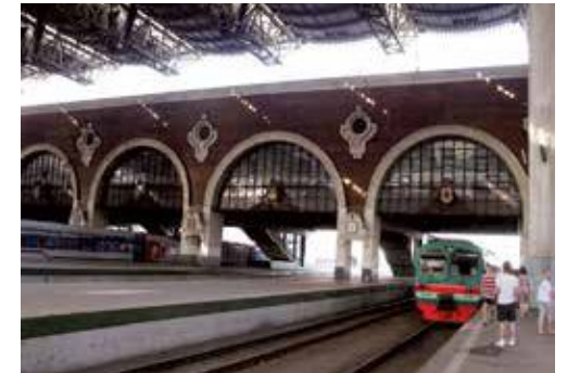
Railway stations Железнодорожные вокзалы
